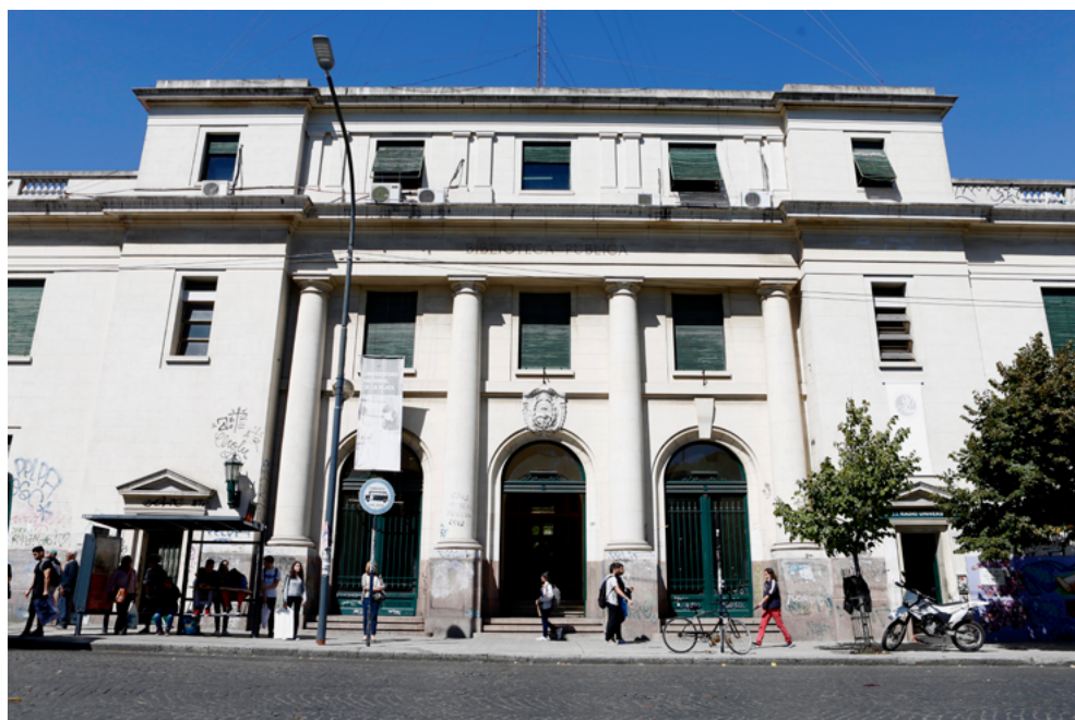
FIGURA 1. Fachada de la Biblioteca Pública de la UNLP.
