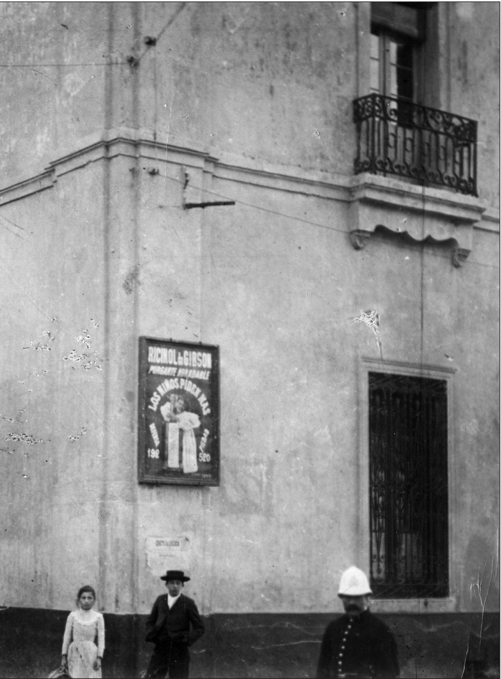
Imagen de la esquina de Moreno y Perú, circa 1900. En el primer piso, hacia Moreno, las ventanas de la Biblioteca.
