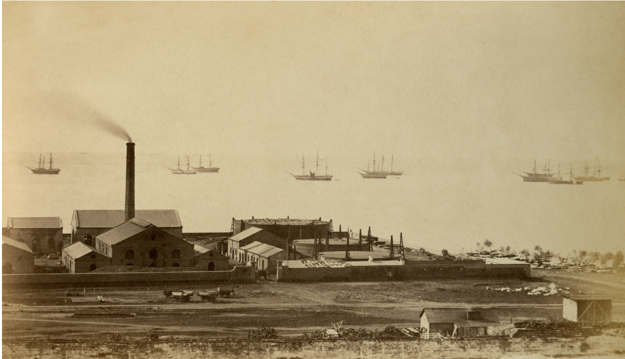
Usina de gas.
